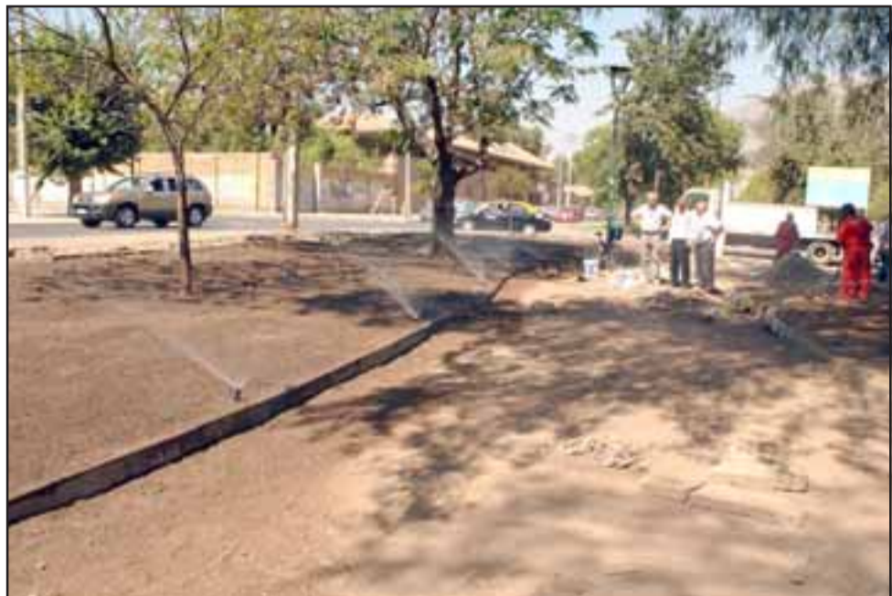
El Administrador Municipal, Patricio González junto al Concejal Dante Rodríguez visitaron algunos sectores de la Avenida Yungay para constatar el avance de los trabajos de mejoramiento.
