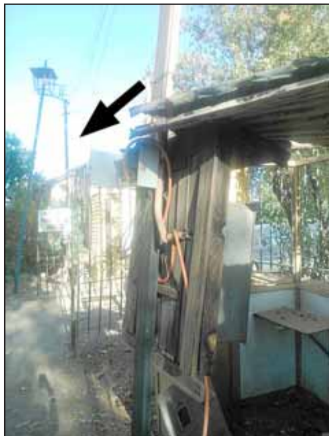
Al fondo, el tubo metálico que se dañó y que habría causado la furia del alcalde sanestebino.
