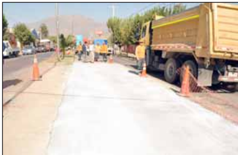
Este proyecto, que comenzó a ejecutarse la semana pasada, contempla reparar las principales vías de la comuna, especialmente los paños más dañados.
