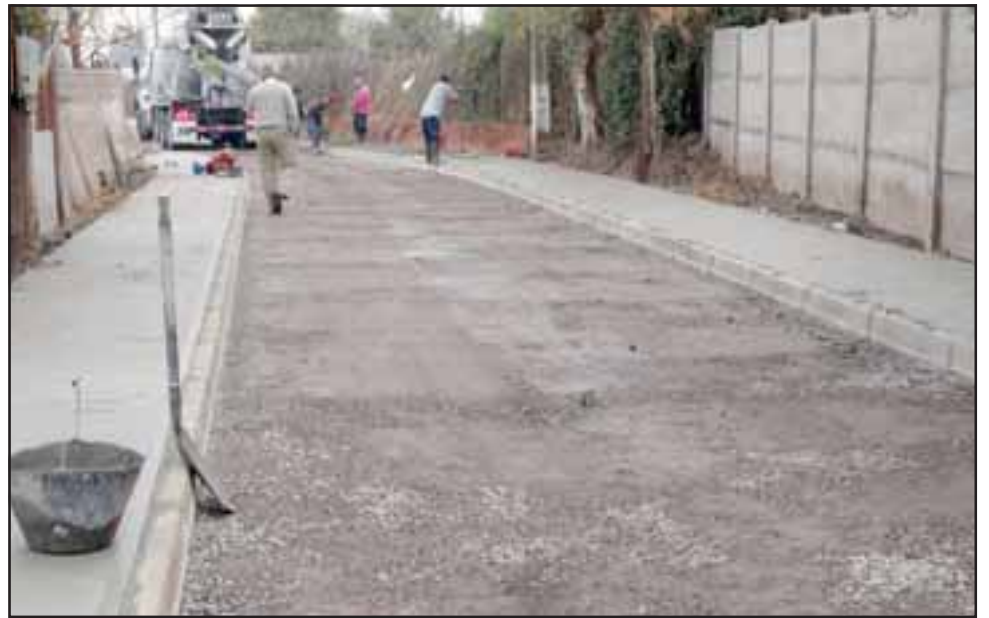
El municipio está realizando diferentes obras, tanto en veredas como pavimentos, para que los vecinos del Patagual puedan esperar el invierno con mejor ánimo.
