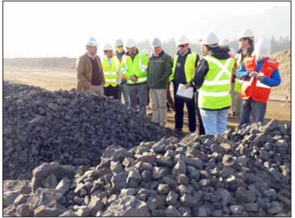
MOP inició el proceso de pruebas para la utilización de la escoria sobrante de la fundición Chagres en la construcción del tramo Panquehue de la nueva ruta CH 60.
