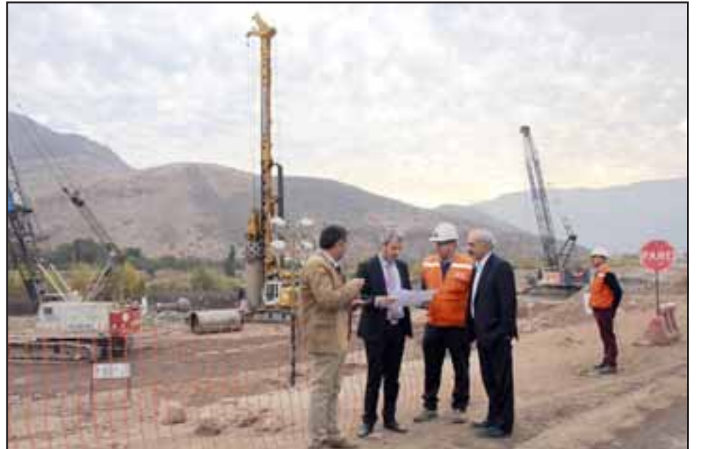
El alcalde, Patricio Freire junto al secretario regional ministerial de Obras Públicas, Miguel Saavedra y el gobernador, Eduardo León, visitaron el avance de las obras de la Ruta 60 CH.
