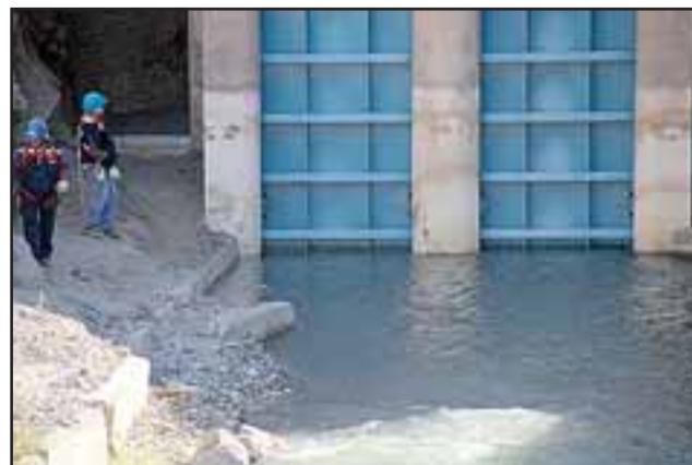
Cerrada la compuerta de la torre de 14 metros de altura, comenzó el llenado de aproximadamente 270.000 metros cúbicos de agua, exactamente el 1% de los 27 millones de litros de agua que podrá almacenar el embalse Chacrillas.
