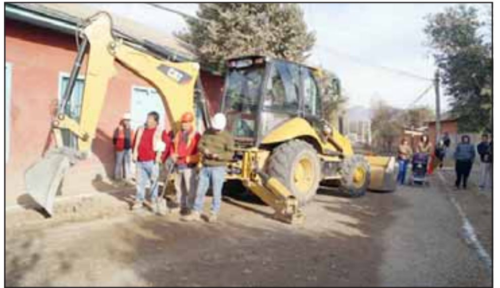
Los trabajos de pavimentación contemplan 806 metros lineales calle La Pampilla y la ruta 57, también la construcción de veredas, evacuación de aguas lluvias, señalización y demarcación.
