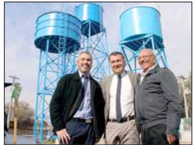
Diversas autoridades inspeccionaron las obras, de mejoramiento del Sistema de Agua Potable Rural de Quebrada Herrera junto al dirigente del APR, Germán Oliví.
