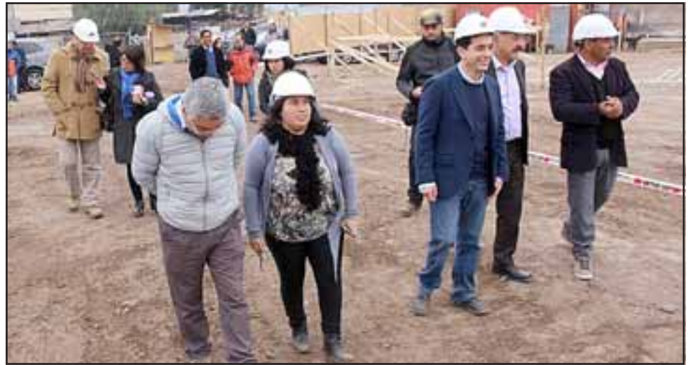
Autoridades junto a beneficiarios en un recorrido por los terrenos donde ya se iniciaron las obras de construcción de las 92 viviendas.
