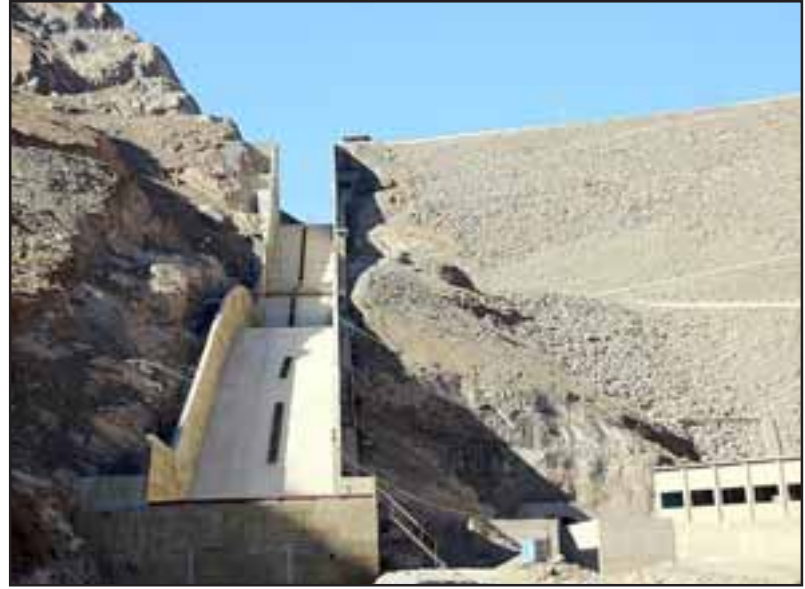
Falta de sellado en los costados de la cortina del embalse habría causado que los 22 milímetros de agua caída no se pudieran embalsar.
