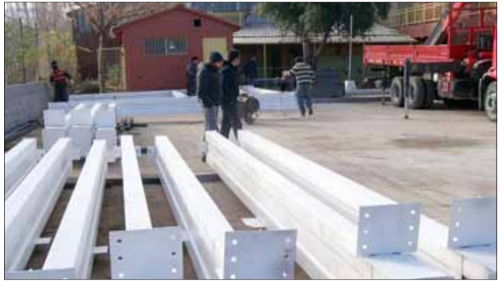
Este martes se comenzó a realizar el grueso del trabajo de construcción del patio techado, utilizando material en acero para brindar mayor seguridad.
