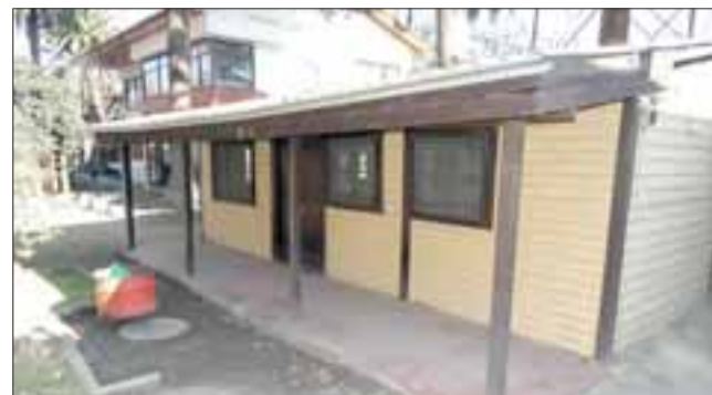
La nueva sede será un edificio de dos pisos que se construirá donde se encuentra una sede de madera, a un costado del edificio de dirección de obras y de la Dideco.
