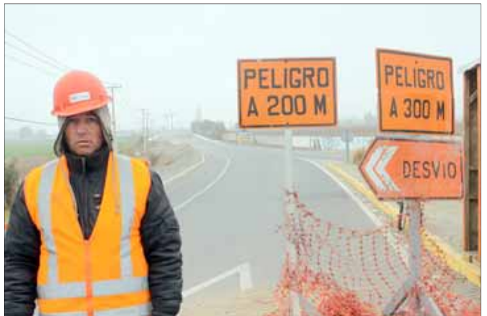
SIN PASO. - Milton Rebolledo, obrero de la empresa constructora, permanecía ayer impidiendo que los conductores usaran la vía.
