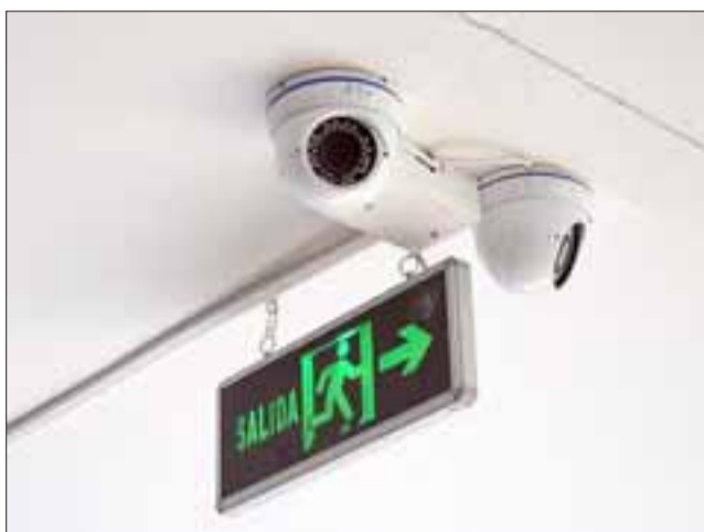
EN ALERTA. - Entre los sectores que ya están cubiertos y que presentaban mayor inseguridad para los usuarios y funcionarios, se encuentra el estacionamiento de las visitas, la entrada principal.
