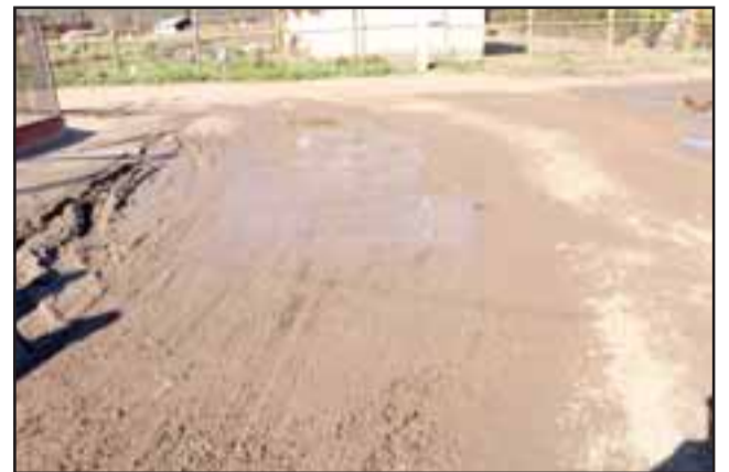
El proyecto 'pavimento participativo' se encuentra emplazado en calle René Ahumada de Población Encón del sector de El Palomar en la comuna de Panquehue.
