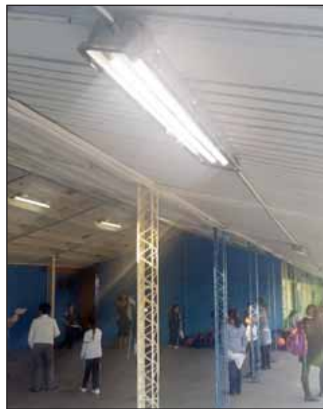
Contempló una mejora estructural, donde el sistema eléctrico era realmente antiguo.
