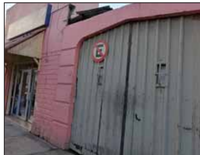
Por este acceso al estacionamiento los delincuentes irrumpieron hasta el local comercial.
