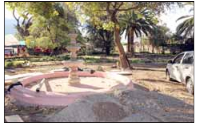
Tras una visita a las obras ejecutadas por la empresa 'JLS', se comprobó que estas registran ya un avance del orden del 70% del total de la obra financiada a través del PMU.
