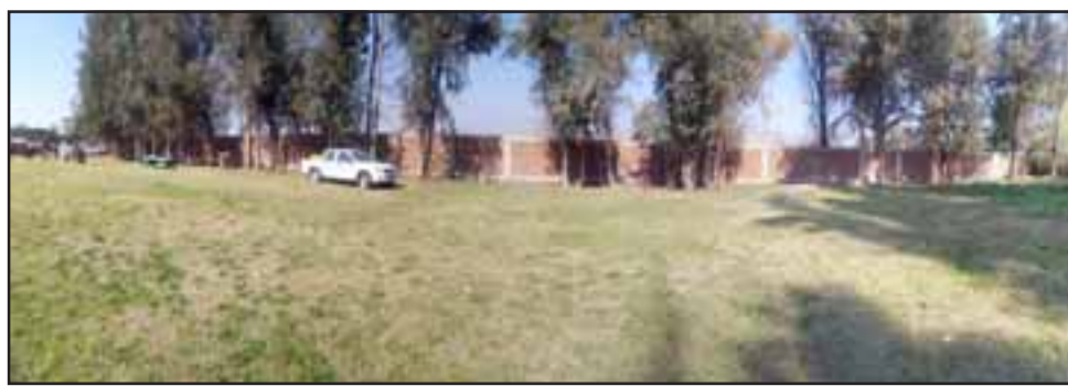
200 metros lineales de muralla de ladrillo en nuevo cierre perimetral de Feria Mayorista de Hacienda de Quilpué.
