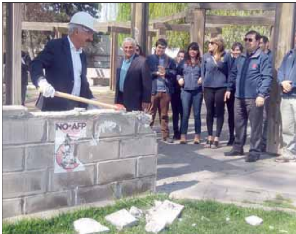
Alcalde de San Felipe Patricio Freire, comenzó con la demolición de la Pérgola de Esquina Colorada.
