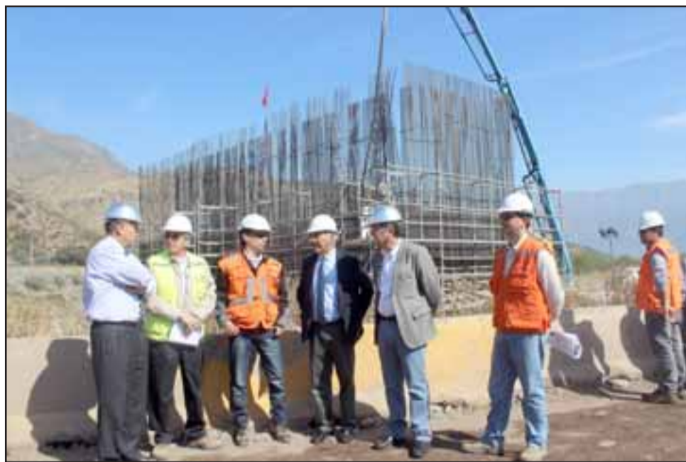
Un 22% de avance alcanza la obra de construcción de la Ruta 60 CH. Así lo dieron a conocer este miércoles, durante una visita del intendente Gabriel Aldoney a la Provincia, junto al gobernador Eduardo León y el alcalde Patricio Freire, quienes arribaron hasta el viaducto en construcción.
