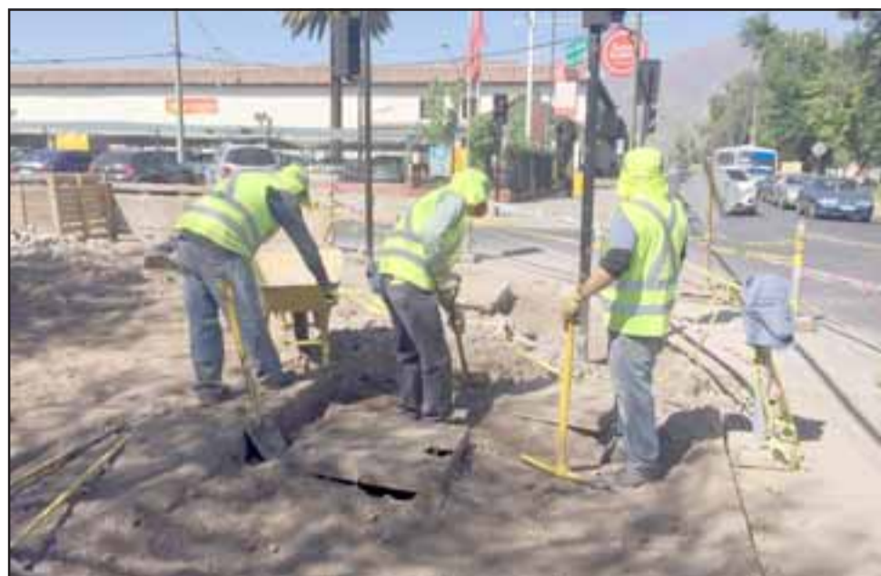
La última etapa del proyecto de cambio de veredas, comenzó a ejecutarse hace unos días en la avenida Yungay, correspondiente al tramo entre Bernardo Cruz y Miraflores.
