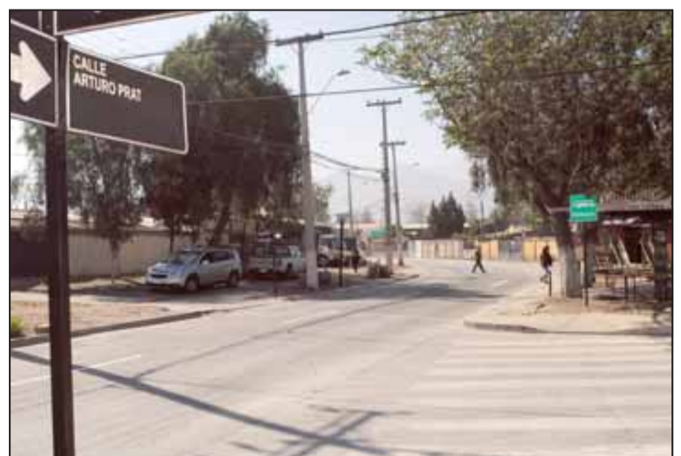
Las obras en la calle Arturo Prat en la actualidad, permiten contar con una repavimentación en carpeta de hormigón de alta resistencia, además de un gran colector de aguas lluvia, un mejoramiento integral favoreciendo así a todos los vecinos de Los Andes.
