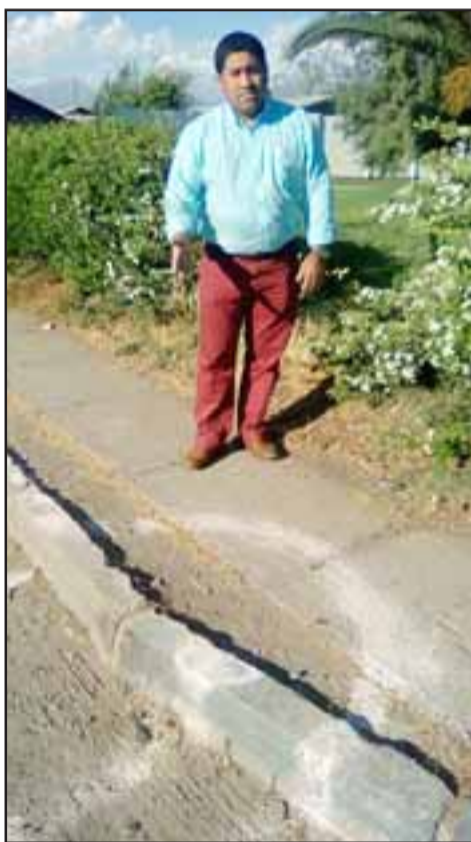
CLAUDIO PANTOJA.- Por fin se ven los primeros avances concretos en las obras de construcción de la red de alcantarillado para Curimón y San Rafael.
