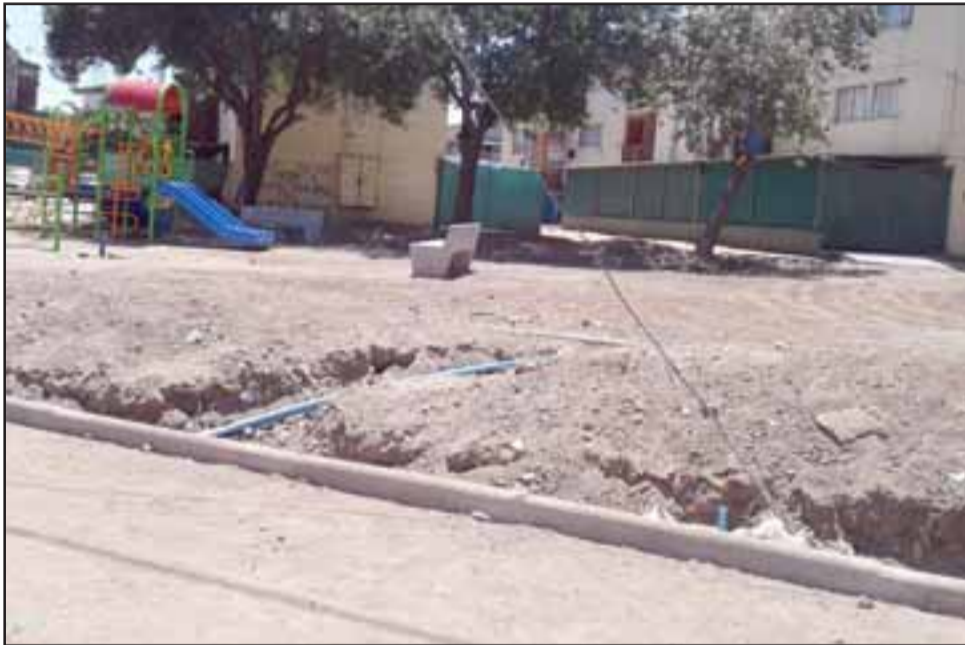
En esta foto podemos apreciar que instalaron una cañería. (Foto gentileza Juan Carlos Sandoval Cariaga).
