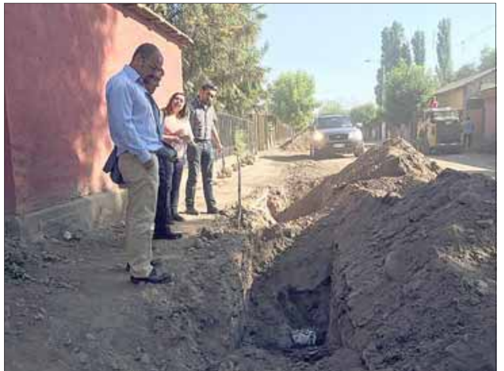
Una visita inspectiva a las obras de construcción del alcantarillado Curimón - San Rafael, efectuó el alcalde subrogante Patricio González.
