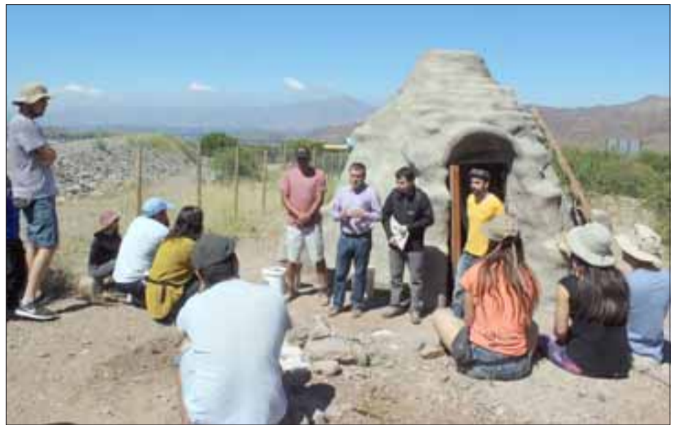
Durante el último fin de semana, se desarrolló el tercer taller. Oportunidad en la que se enseñó técnicas de construcción en quincha, súperadobe y revestimientos o revoques naturales.
