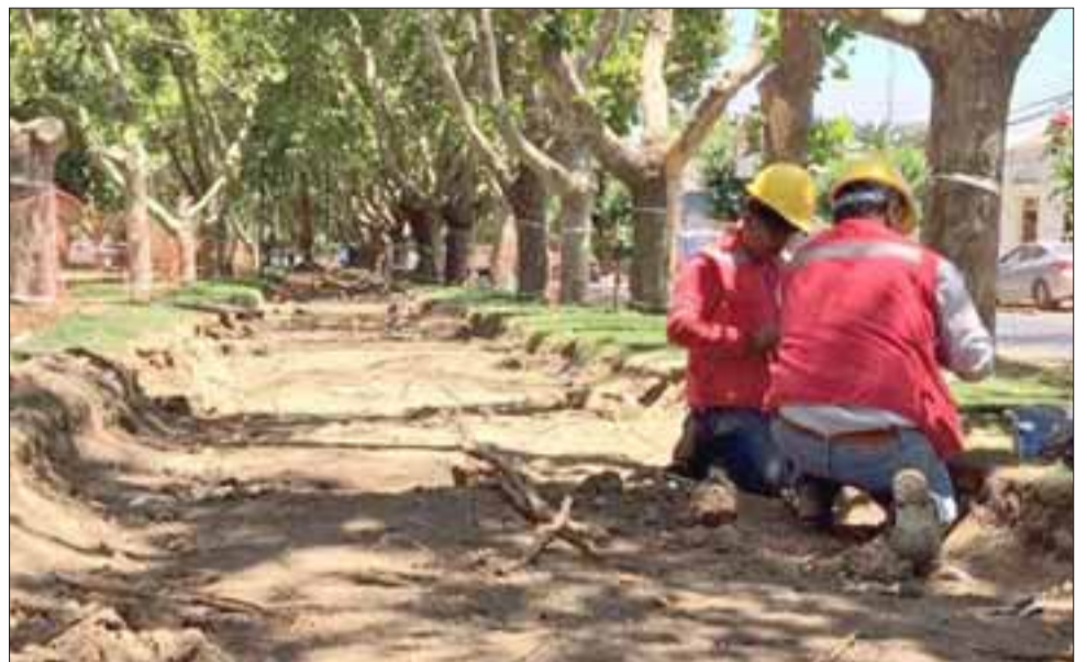
En las zonas a intervenir, se ejecutarán: pavimento de calzada de ciclovías, aceras, dispositivos de rodados (rampas para minusválidos), señalización, demarcación, mejoramiento de sistemas de aguas lluvias, biciestacionamientos, entre otras faenas.
