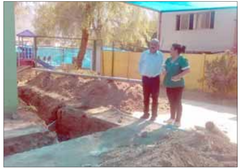
Alcalde Freire, visitó las obras que se encuentran en plena ejecución, lo que obligó el traslado momentáneo de los alumnos al Liceo San Felipe.
