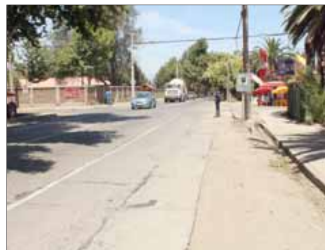
Los recurrentes accidentes de tránsito y atropellos, registrados en el cruce vial de la calle Antofagasta con la ruta CH 60, sirvieron de base para preparar un proyecto, que permita la instalación de semáforos.
