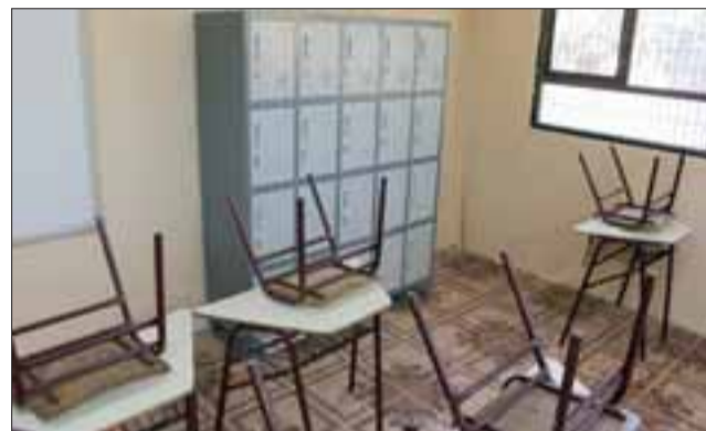
Las Obras apuntan a mejorar las condiciones de los espacios donde los alumnos estudian y permanecen gran parte del día, por lo que la apuesta de ofrecerles lugares cómodos, bonitos y modernos
