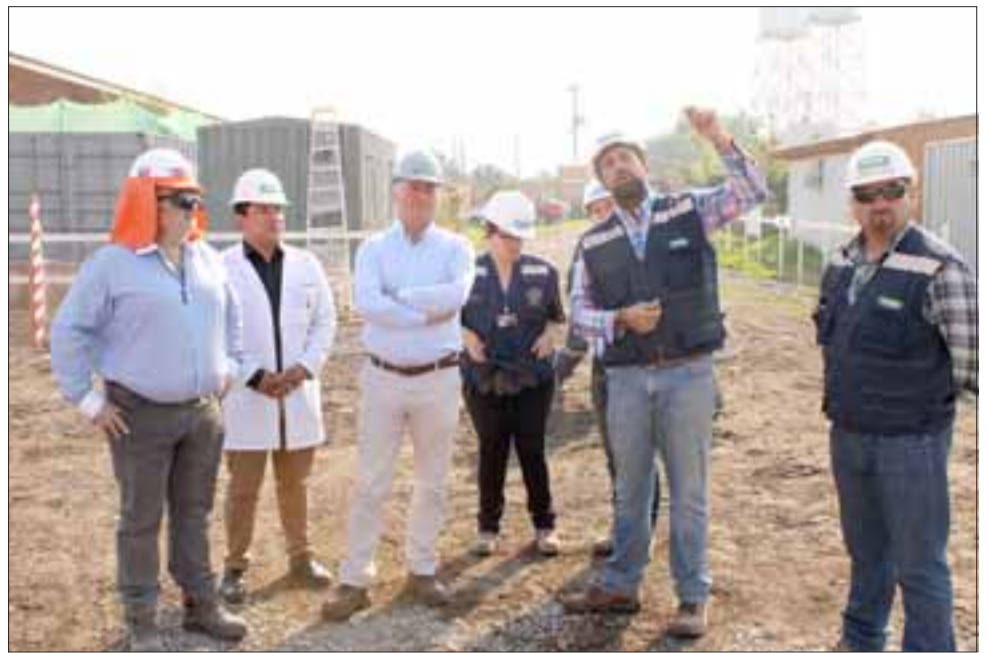
El alcalde Luis Pradenas Morán, acompañado por el director del Cesfam el Dr. Teófilo Reyes junto a la directora de Obras Loreto Galdames, el secplac Sebastián Brito, además representantes de la Constructora Polonesa, pudieron conocer en terreno el avance de las obras.
