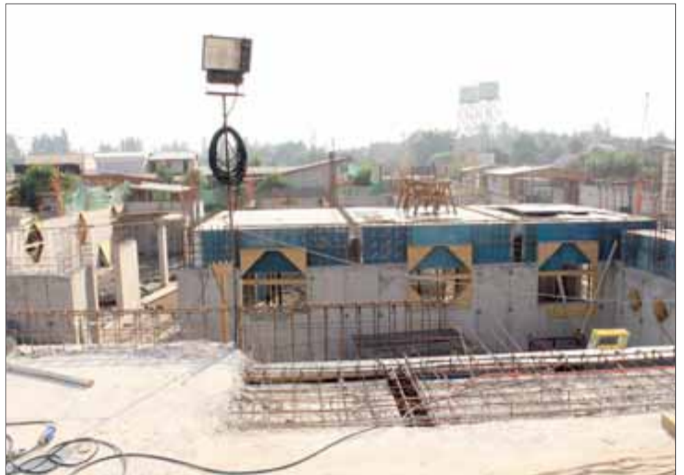
Las obras que tienen un avance del 20% y en julio de este año, deberían estar terminadas y listas para su utilización.
