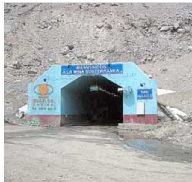
Un trabajador de planta de la División Andina de Codelco murió la mañana de ayer jueves, al caer a un buzón al interior del nivel 17 de la mina subterránea.
