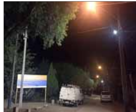
Visiblemente más iluminada luce la ladera del cerro de Villa Paso El Bermejo.
