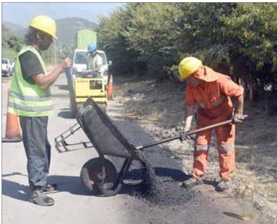
Así marchan los trabajos de bacheo asfáltico que se están realizando en la comuna, el cual comenzó en el sector de Las Vegas.
