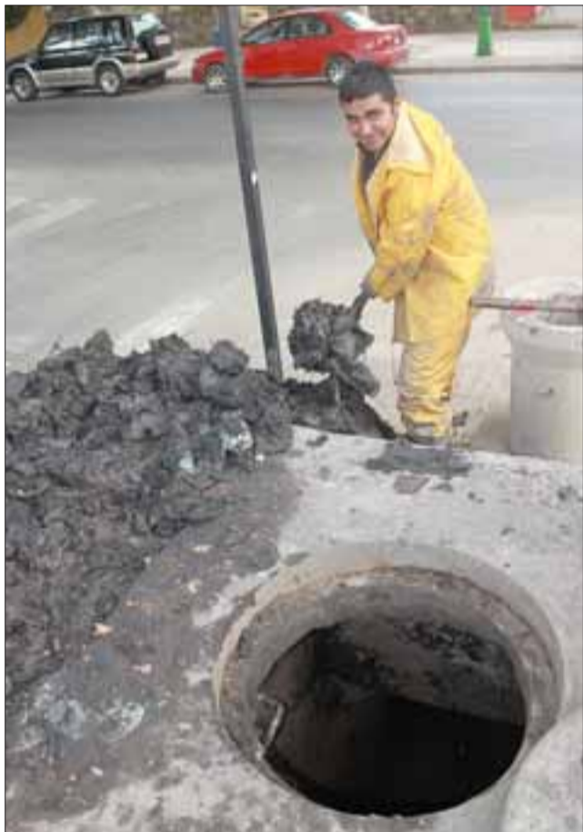
LIMPIEZA TOTAL.- Juan Montenegro trabajaba entre el lodo y los escombros, material que muchas veces llega a esas cámaras cuando algunos 'vecinos del Año' los arrojan al canal.
