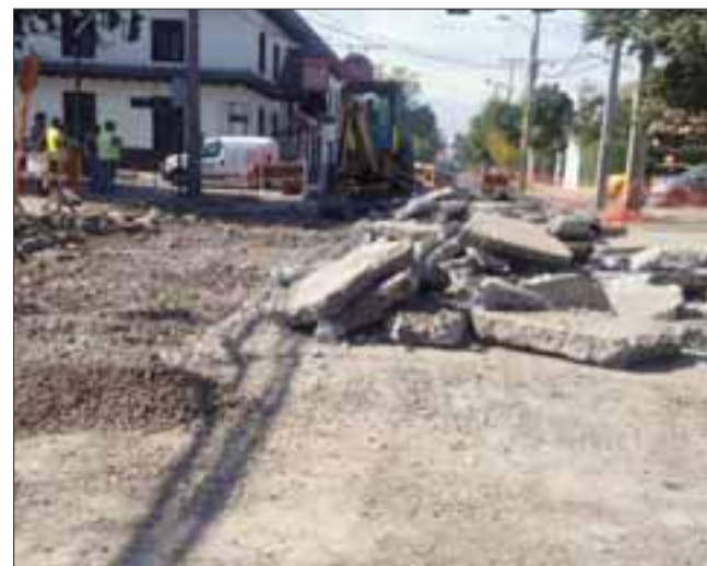
Este fue el lugar donde se removió el pavimento por hallazgo de estanques de combustible.
