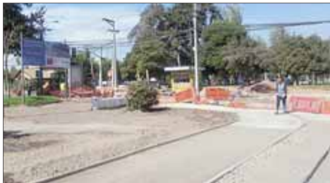
Personal efectuando trabajos en intersección de Yungay con Prat.
