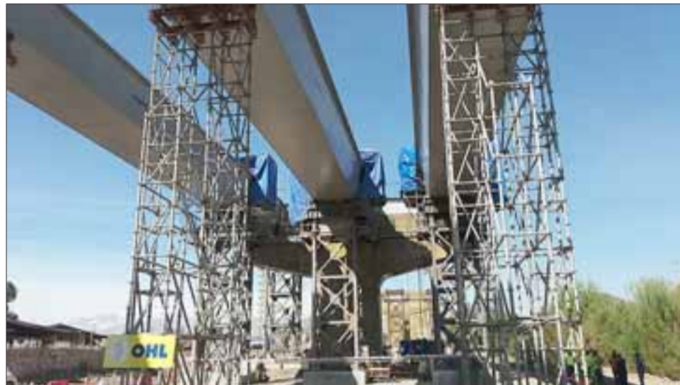
La mega obra avanza según lo estimado, superando ya el 50 por ciento.
