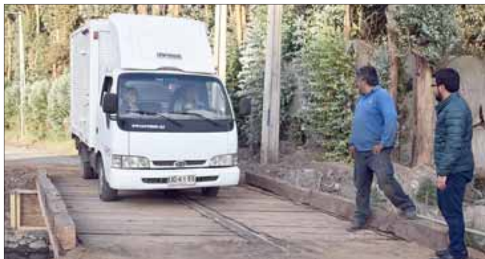
Tras colapso de la estructura, la municipalidad comenzó los arreglos, los cuales concluyeron el día de ayer dejándolo habilitado con un peso máximo de cinco toneladas.
