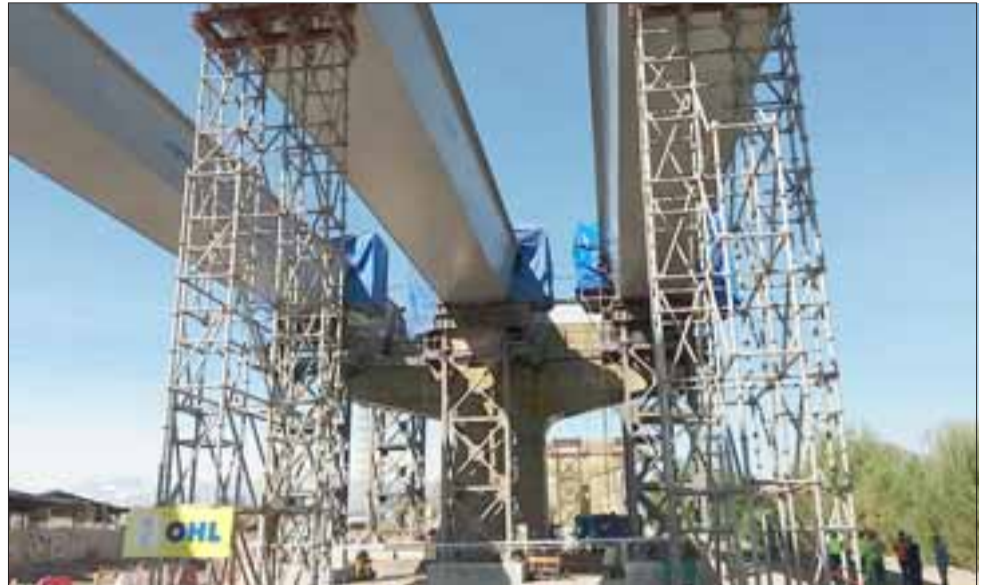
Los cortes se realizarán desde las 9 y hasta las 18 horas durante estos tres días, cuando se instalen las gigantescas vigas en el viaducto de acceso a San Felipe.
