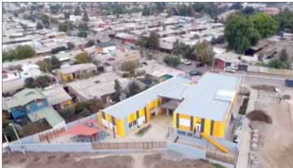
El nuevo jardín infantil cuenta con dos salas cuna y dos niveles medios y constituye un recinto de primer nivel, con tecnología de punta y espacios amplios y luminosos.
