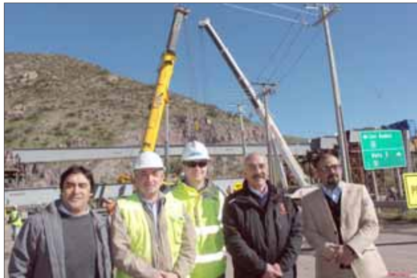
PARA MARZO 2018.- Las autoridades del Municipio visitaron ayer jueves las obras durante la instalación de la segunda viga sobre Puente El Rey.
