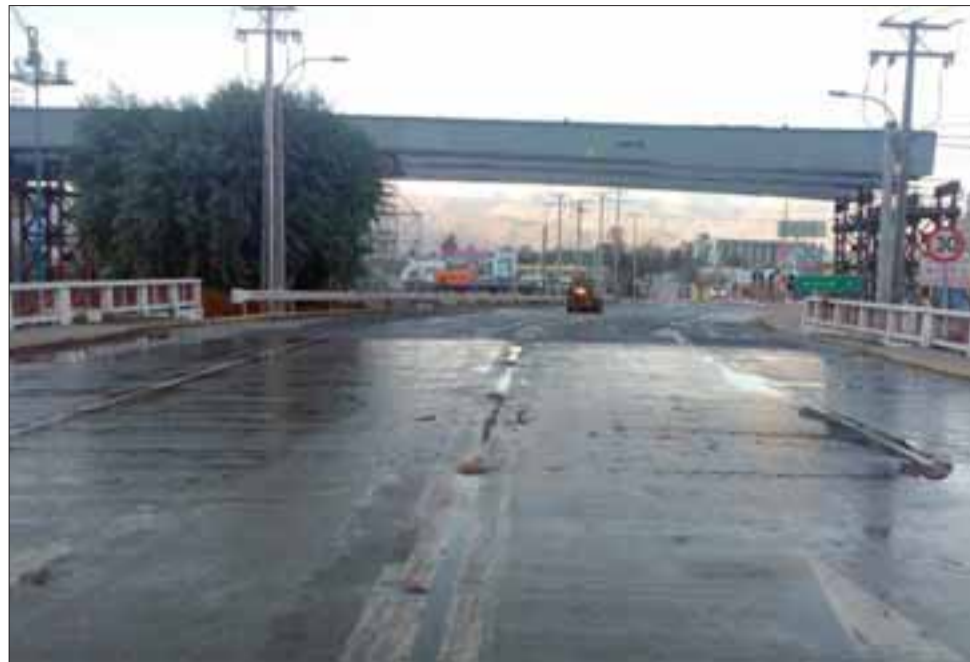
Las obras de la Ruta 60 CH en el tramo Panquehue superan el 60% de avance y ya se está trabajando en la preparación para iniciar el proceso de asfaltado.
