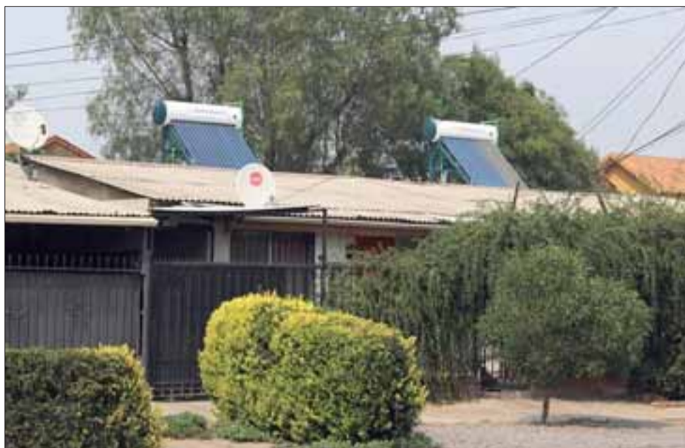
Algunas de las casas que ya cuentan con termo calefactores solares en la Villa Cordillera, programa que también ha sido bastante exitoso.
