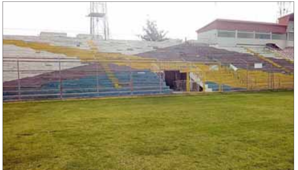
Tribuna Poniente del Estadio Municipal de San Felipe, será sometida a remodelación de sus tableros a partir del mes de octubre.
