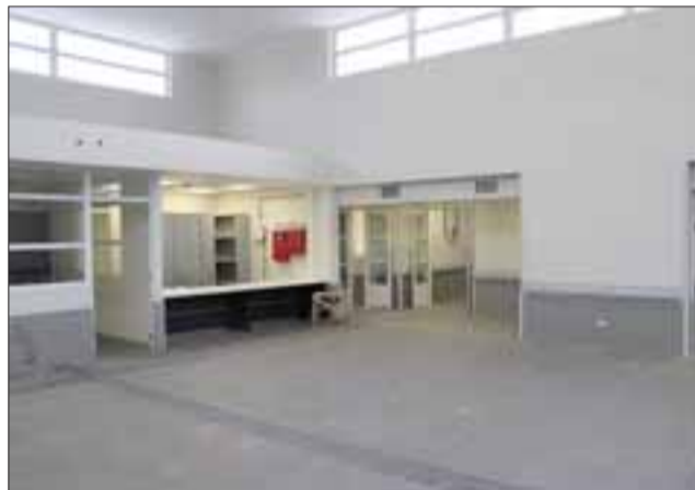
El nuevo Cesfam de Panquehue presenta un avance del 95 por ciento, estimándose que en octubre ya estará operativo.
