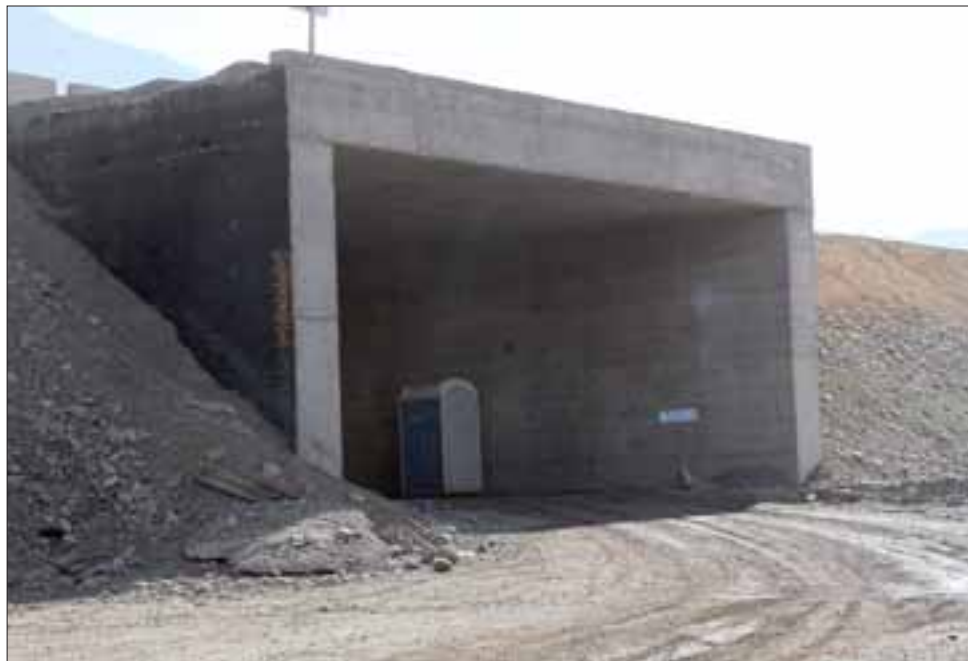
El proyecto que registra un avance del 70%, debería estar terminado en diciembre, para estar operativo los primeros meses de del 2018.
