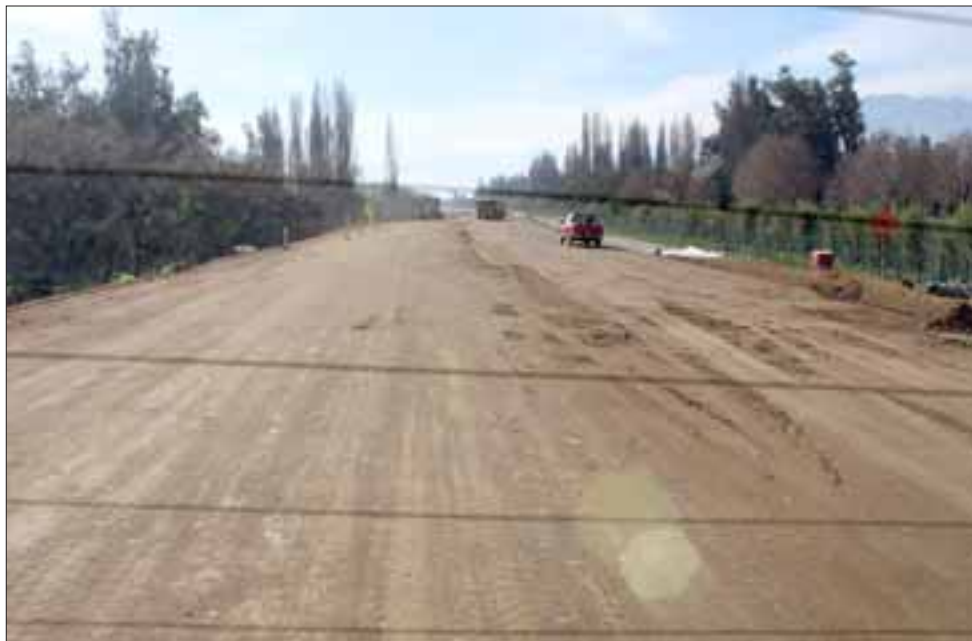
En la obra actualmente trabajan cerca de 900 personas, con una gran cantidad de maquina pesada, con el fin de terminar una carretera con el más alto estándar. En la gráfica uno de los puentes.
