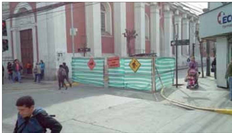
Tránsito vehicular en Combate de las Coimas -entre Prat y Santo Domingo- estará suspendido durante un mes aproximadamente.
