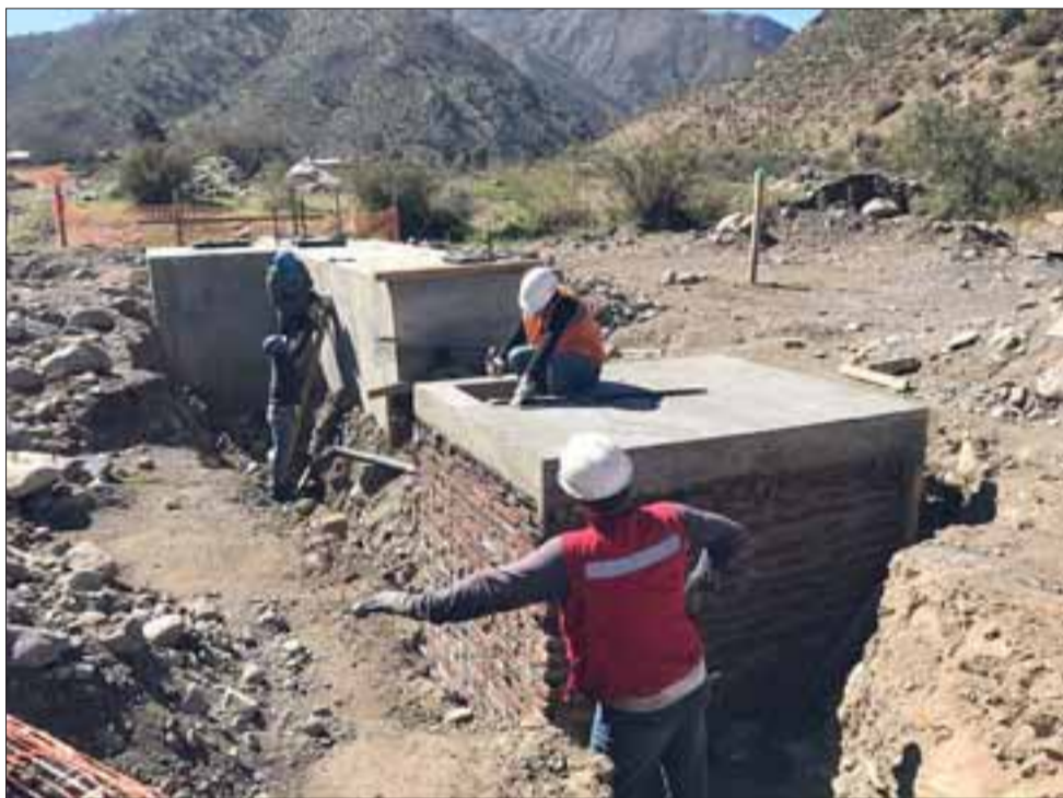
Las obras del nuevo punto decantador de aguas avanzan rápidamente, asegurando la continuidad del suministro al APR de Casablanca.
