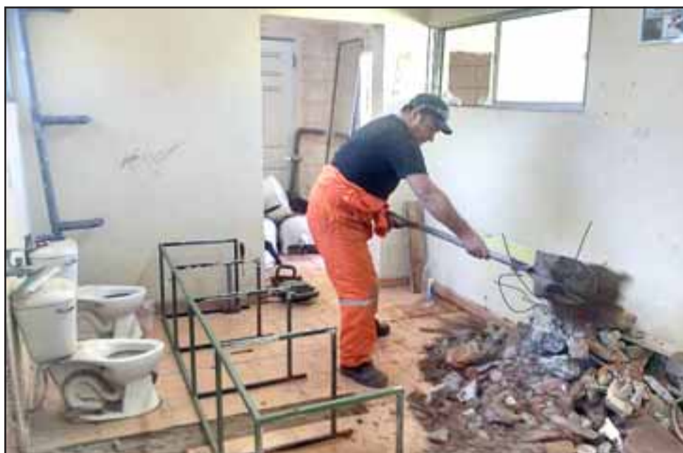
Una inversión de cuatro millones de pesos permitirán renovar por completo los baños de los más pequeños de la Escuela, instalaciones que no eran intervenidas hace 20 años.
