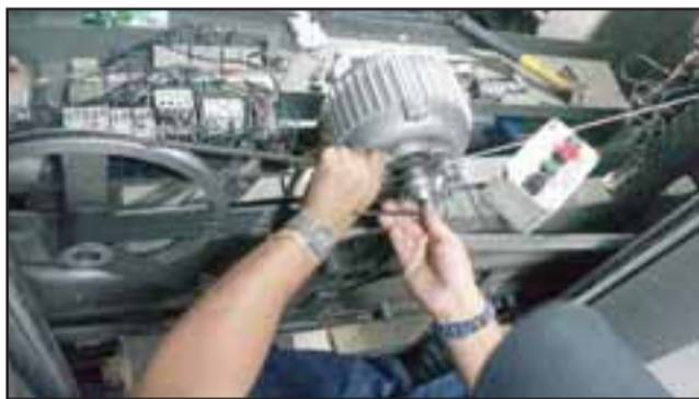
EN ESPERA. - En las próximas semanas, según Pizarro, estaría en pleno funcionamiento el ascensor de la Gobernación. (Referencial)
