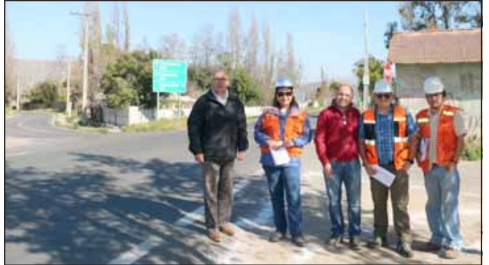
El alcalde Guillermo Reyes y la directora provincial de Vialidad, Claudia Lizama, junto a representantes de la empresa a cargo de los trabajos de mejoramiento en el cruce 'Las Quillotanas'.
