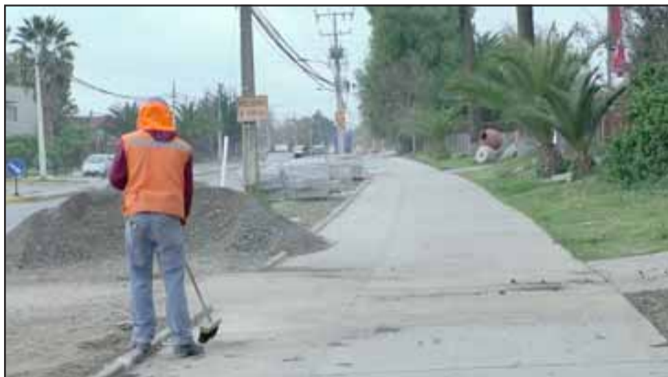
Quinientos metros lineales de ciclovías, de los 1.600 contemplados, ya se han construido en el camino Tocornal.
