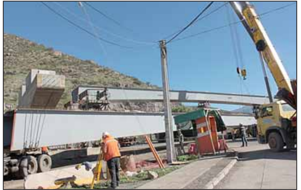
Esta semana, entre hoy lunes y el lunes 9 de octubre, el acceso a San Felipe por Puente El Rey sufrirá una restricción de tránsito vehicular debido a la construcción de las lozas que necesita el viaducto.
